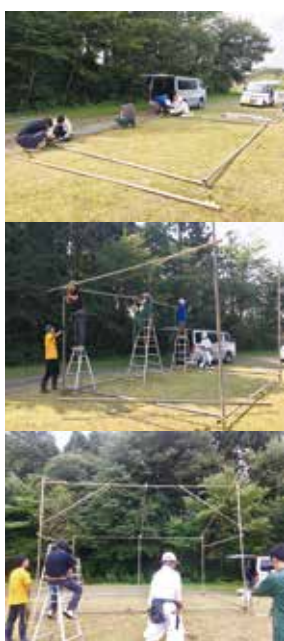
足場材でステージ屋根を作成
