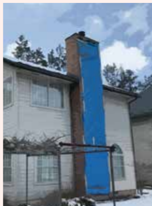
火災箇所をブルーシートで養生中
